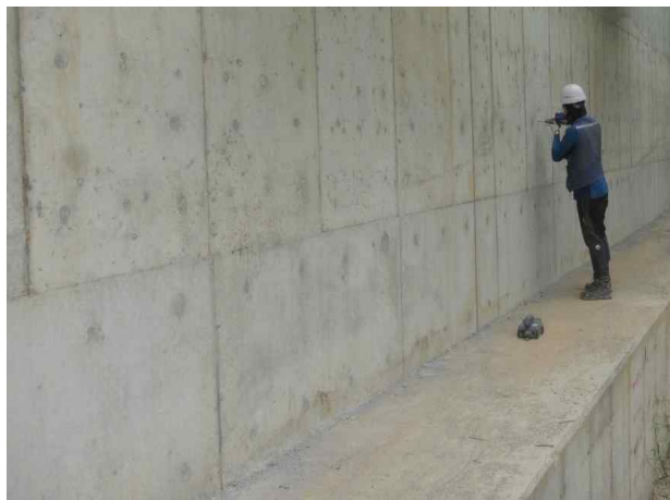
A2 벽체 전면 반발경도시험 전경
