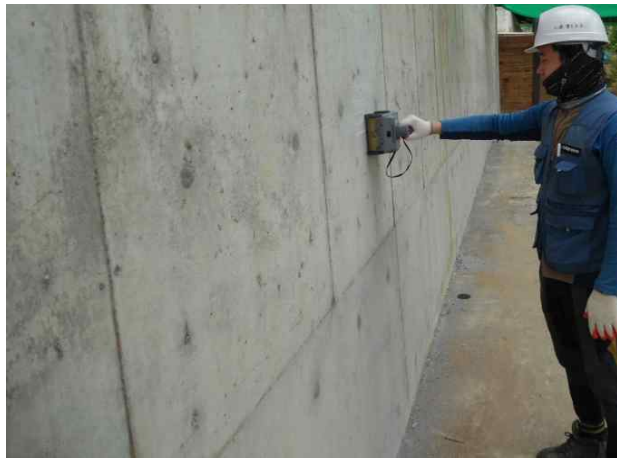
A2 벽체 전면 철근배근탐사 전경
