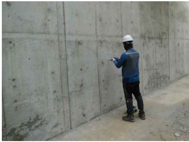
A1 벽체 전면 반발경도시험 전경
