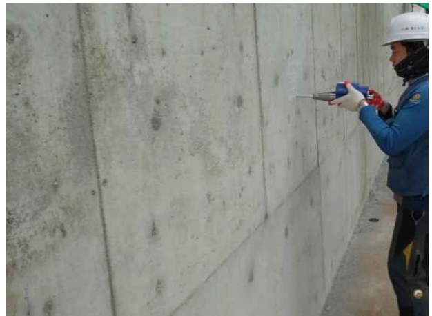
A2 벽체 전면 반발경도시험 전경
