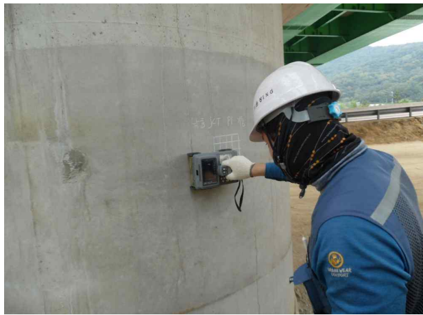
P1 기둥부 철근배근탐사 전경
