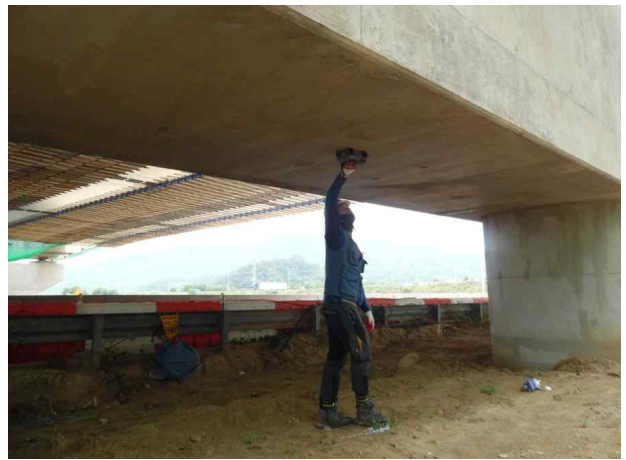
P2 코핑 하면 철근배근탐사 전경
