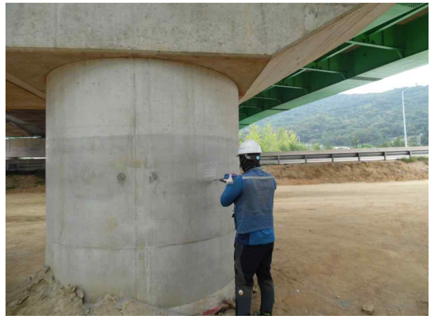
P1 기둥부 반발경도시험 전경
